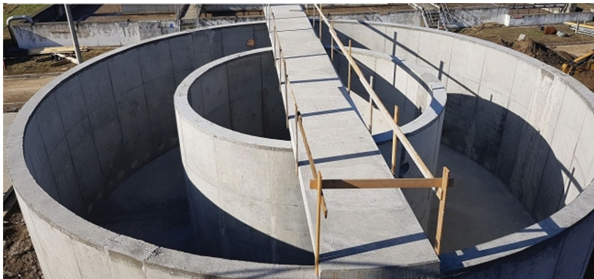
Zakończone konstrukcje zbiorników uśredniającego i buforowego
