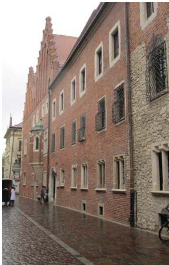
Wschodnia fasada budynku Collegium Maius od strony ulicy Jagiellońskiej.
