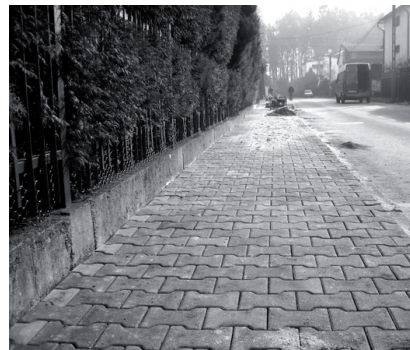
os. Leśne w Kętach - kostka z rozbiórki
