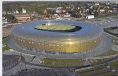
Dach stadionu PGE Arena zrealizowany w systemach Aluprof i wykonany przez Metalplast Stolarka
