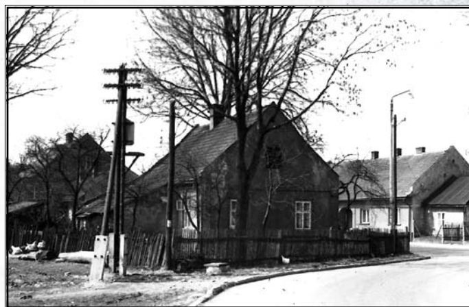
rok 1970 - Wylot ul. Słonecznej na ul. Krakowską. Budynek p. Jarosz – dziś jest tam rondo.
