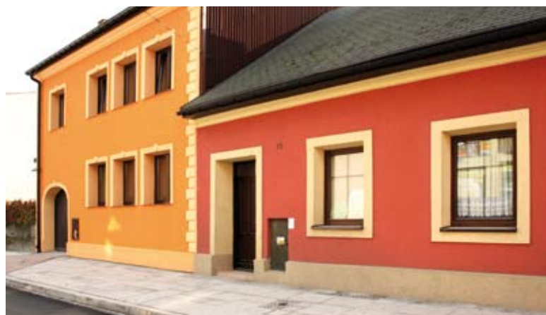
odremontowane domy przy ul. Krakowskiej
