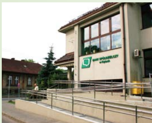
Od strony ul. Stojałowskiego wybudowaliśmy podjazd dla osób niepełnosprawnych
