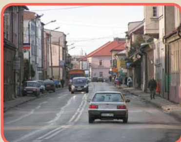
Ulica Krakowska przed rozpoczęciem prac modernizacyjnych.
