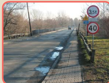
Obecny stan mostu.
