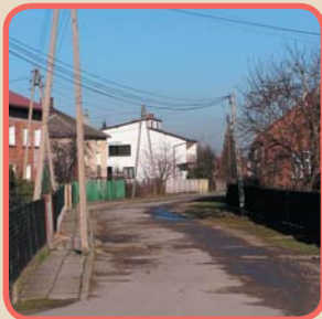
Ulica Staszica przed przebudową.
