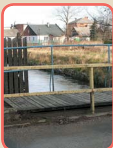
Most na potoku Młynówka przed przebudową.
