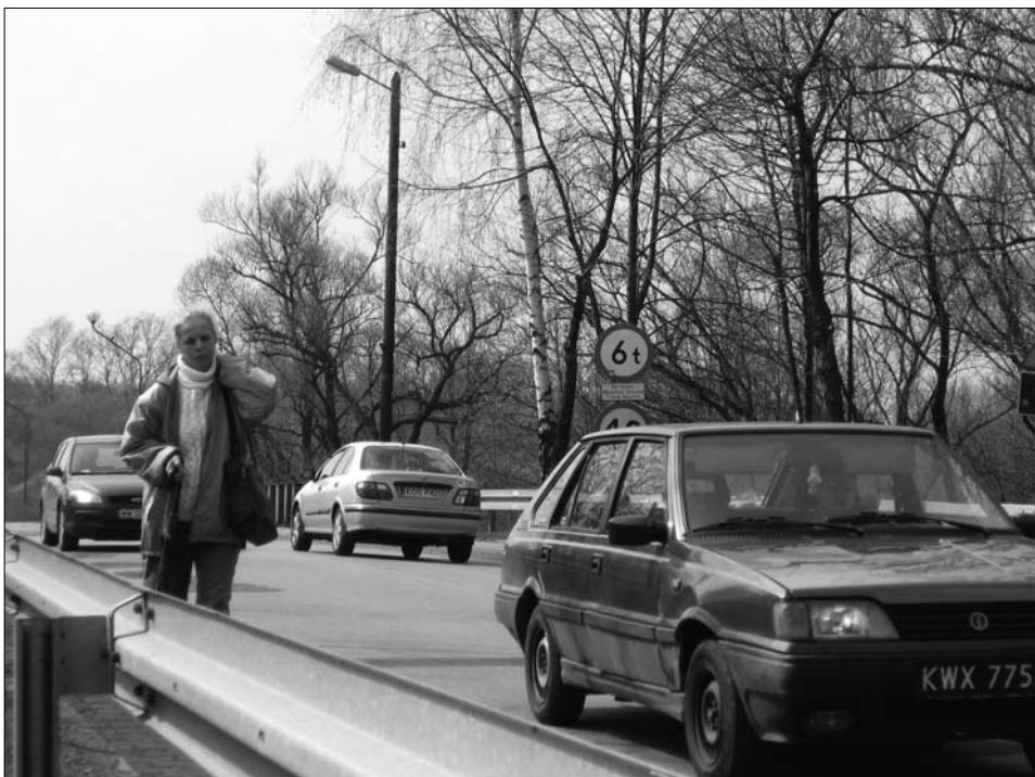
Koszt remontu mostu oblicza się na ok. 4 mln zł.
