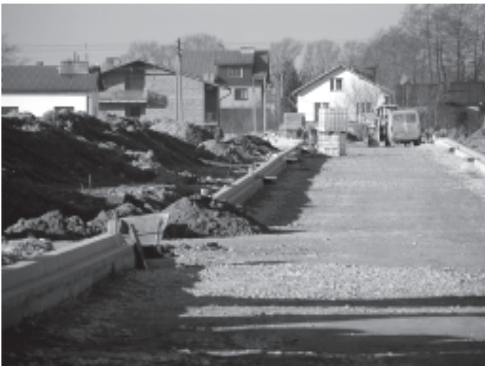
PRACE IDĄ PEŁNĄ PARĄ
