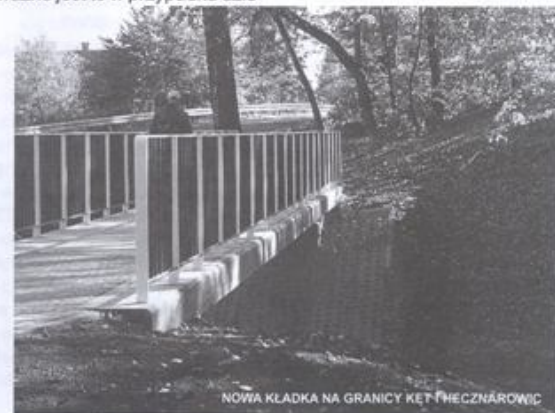
NOWA KŁADKA NA GRANICY KĘT I HECZNAROWIC
