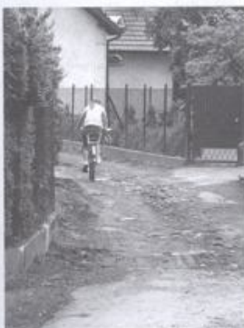
PRACE KANALIZACYJNE NA ULICY RAJSKIEJ - CHODNIK
