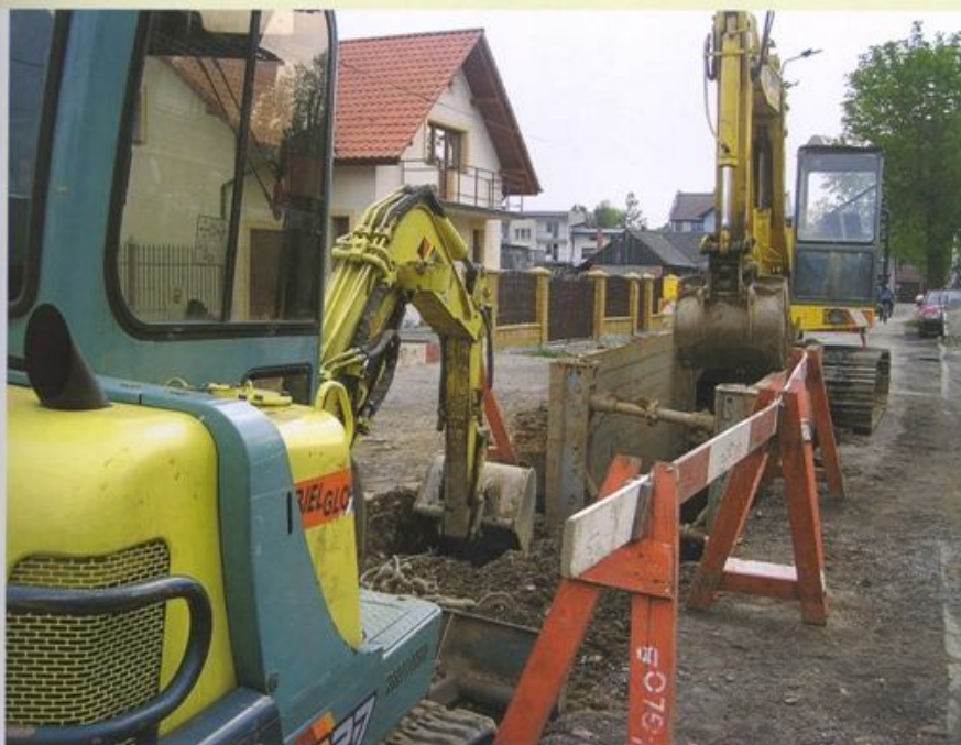
Prace kanalizacyjne na ul. Konopnickiej w Kętach
