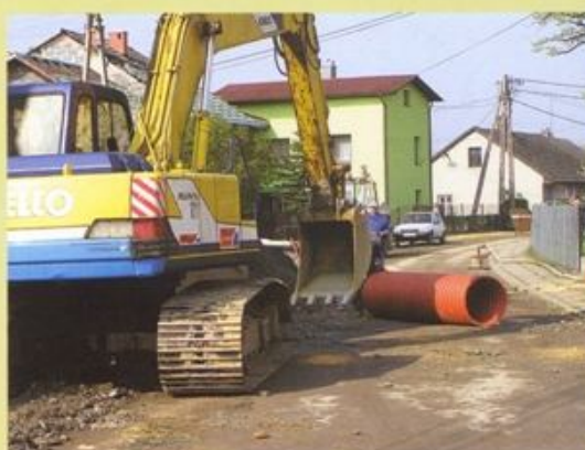
Prace kanalizacyjne w Nowej Wsi
