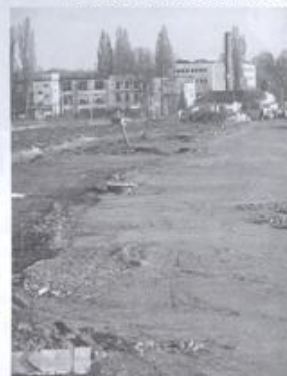
ODCINEK PROWADZĄCY DO UL. MICKIEWICZA
