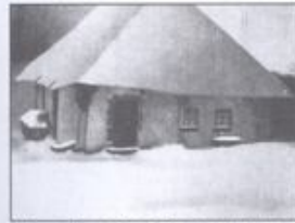
Elewacja zachodnia starej chatynki od strony ogrodu. Rok 1893.
