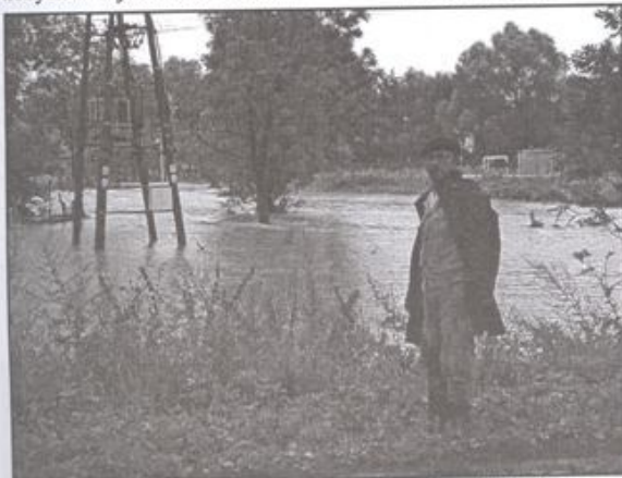
Na ulicy Głowackiego woda podeszła pod rozdzielnię gazu i transformator elektryczny. Fot. (nik).
