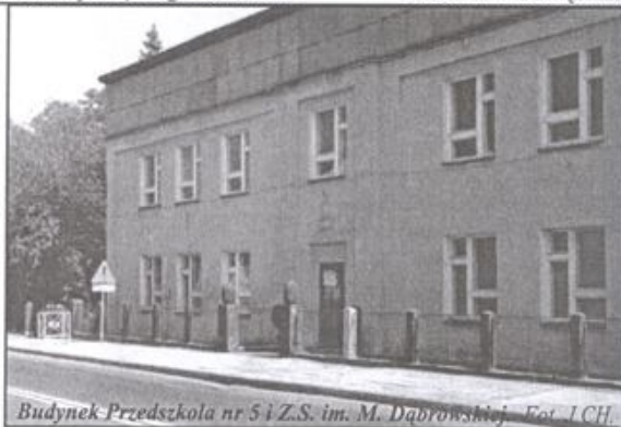
Budynek Przedszkola nr 5 i Z.S. im. M. Dąbrowskiej. Fot. J.C.H.
