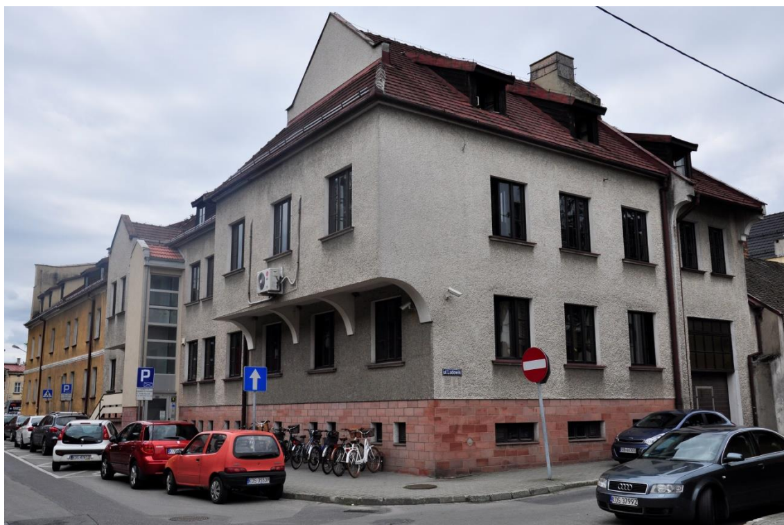
Fot. 1. Budynek Urzędu Gminy Kęty. Stan przed realizacją projektu.
