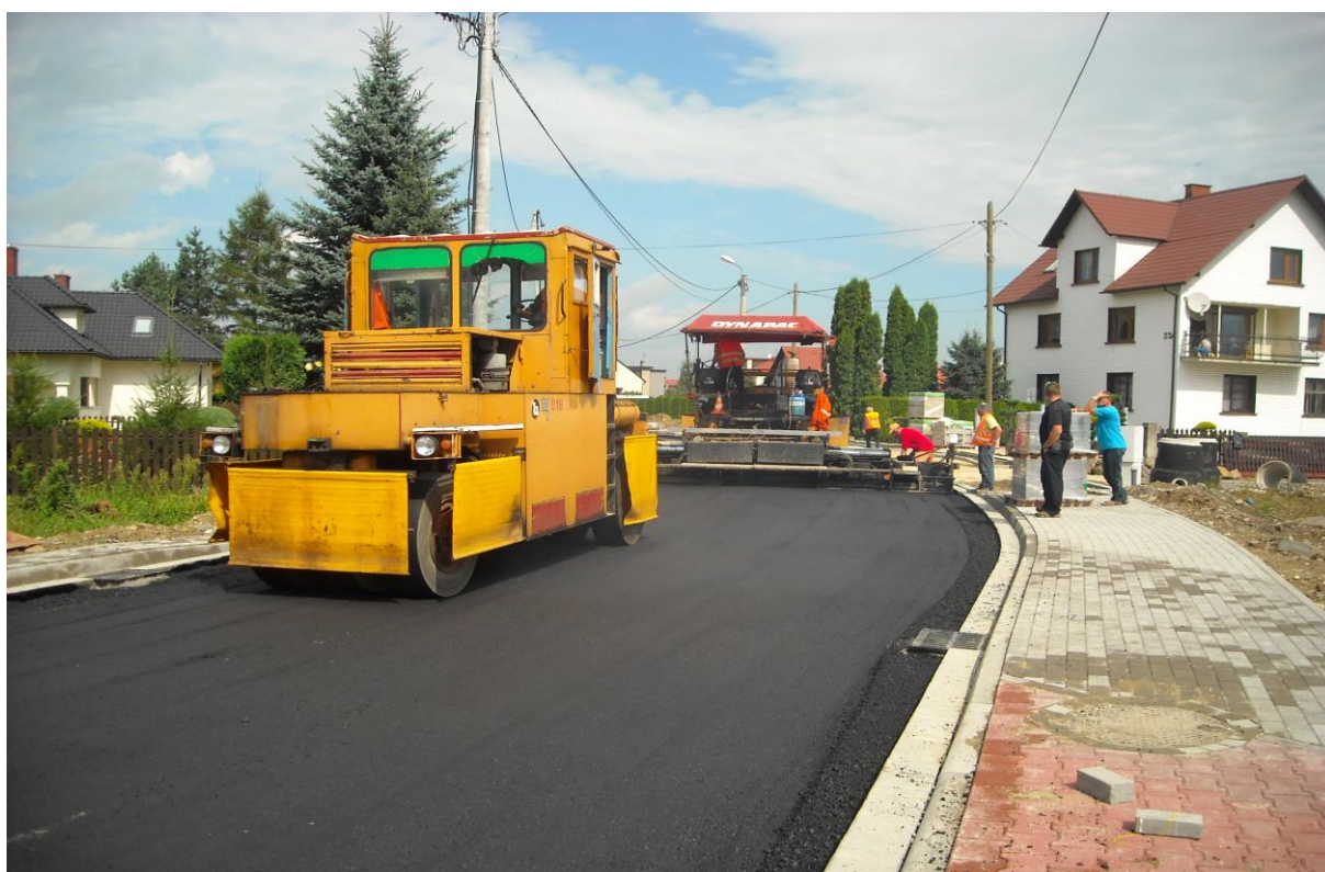
Fot. 5 – prace związane z układaniem nawierzchni bitumicznych na jezdni
