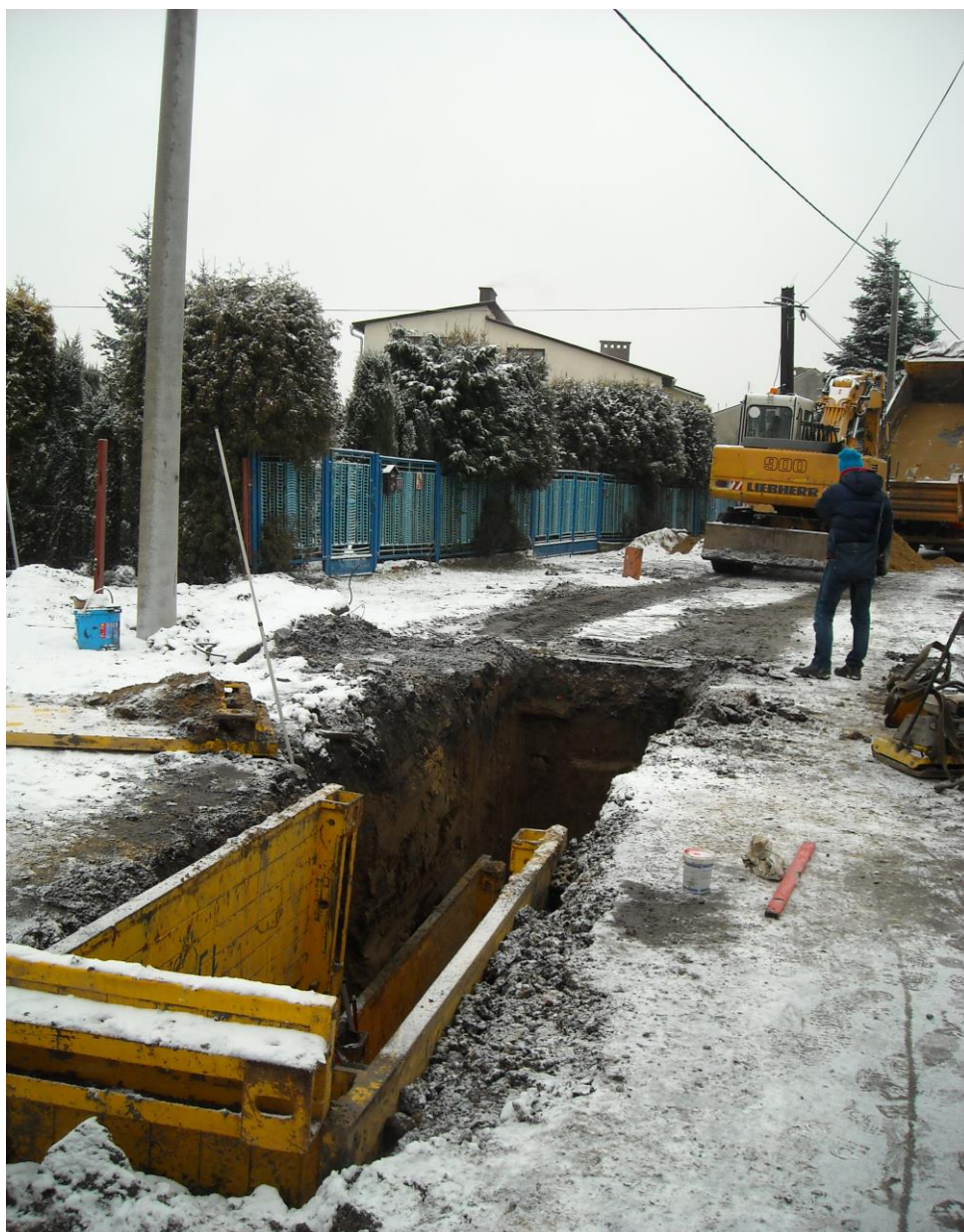
Fot. 2 – prace prowadzone w okresie zimowym związane z układaniem kanalizacji
