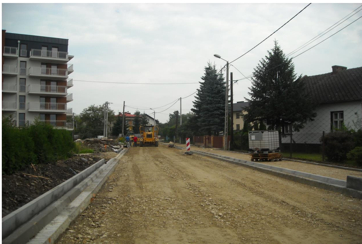
Fot. 4 – prace związane z budową konstrukcji jezdni i chodnika
