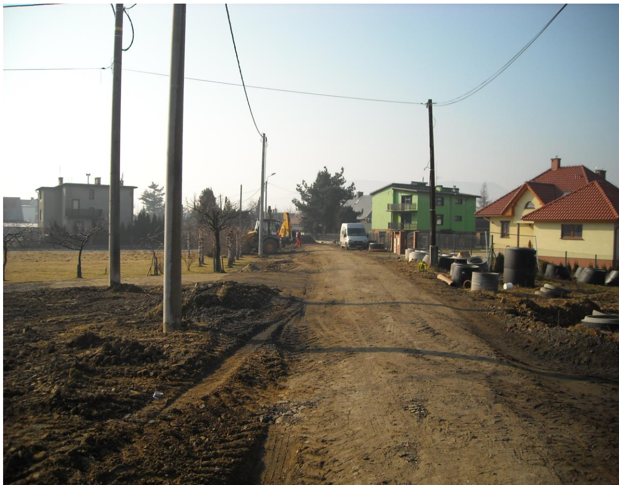
Fot. 3 – rozpoczęcie realizacji zadania w zakresie przebudowy sieci elektroenergetycznej i teletechnicznej
